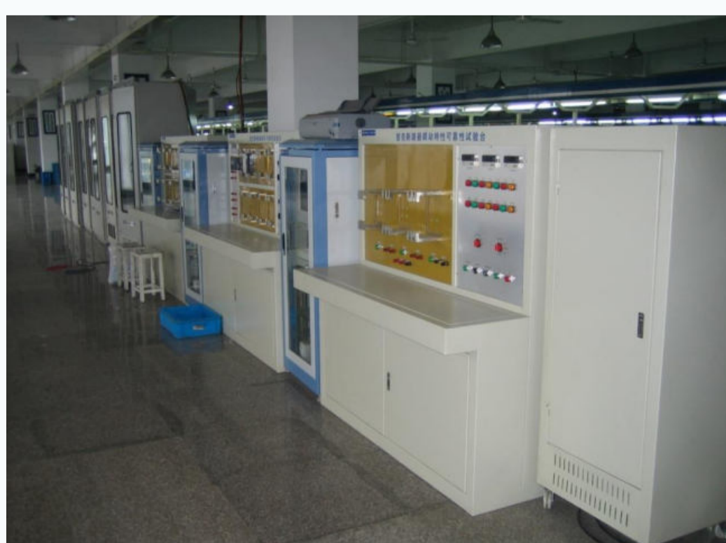
为“人民电器集团有限公司”建立的电器可靠性实验室
