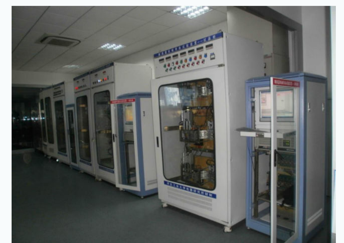
为“长城电器集团有限公司”建立的电器可靠性实验室
